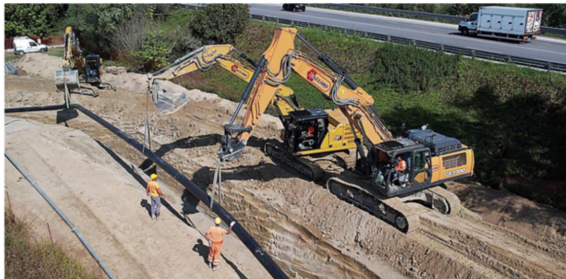
Lavori per la posa di grandi condutture del gas: i lavori sono già in corso in Abruzzo
